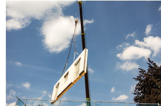
**Bild 4.** Die TextureWall genannte Wandkomponente für mobile Häuser verfügt über Putzoptik. Sie ist witterungs- und UV-beständig und deshalb sehr langlebig
