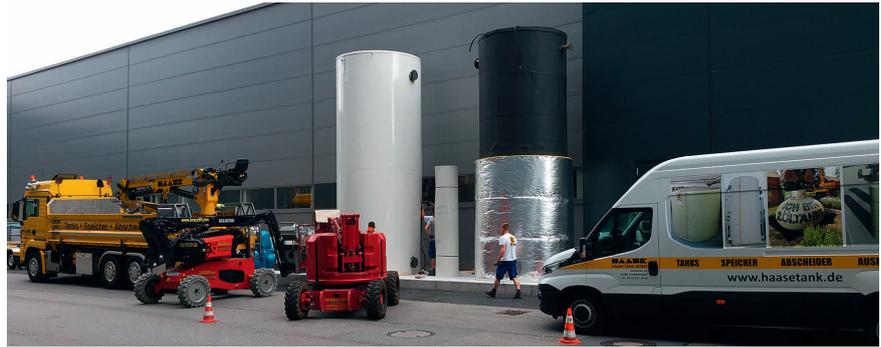
**Bild 3.** Montage gedämmter GFK-Wärme- und Kältespeicher, die in Kombination mit Wärmepumpen Prozesswasser eines Fruchtsaftherstellers heizen und kühlen (© Haase Tank)
